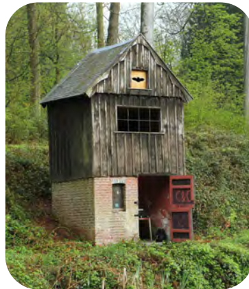
Aménagement d'un comble dans le cadre des JAC sur La Hulpe par l'asbl La Hulpe Nature.
