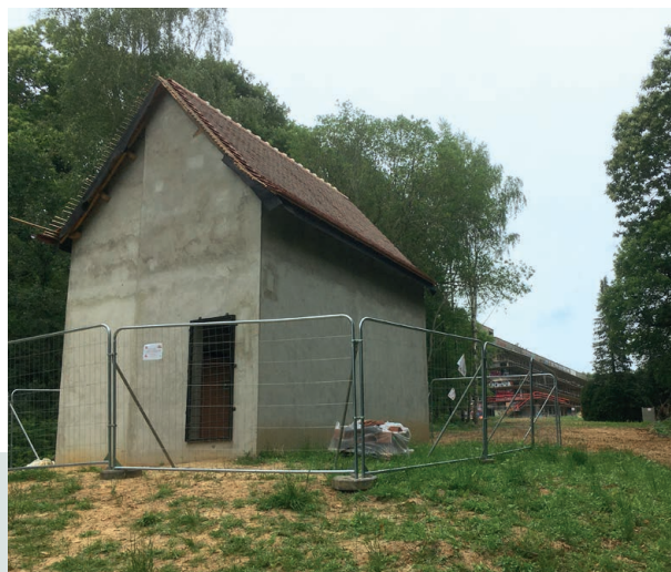
| Nouveau gîte en construction
