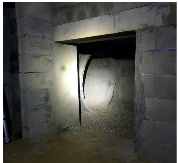
| Le tunnel de transit
