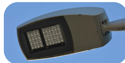
La nouvelle lampe installée est plus directionnelle et utilise des LED.
