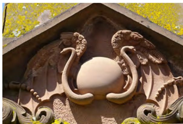
Pour conclure, retour à Sélestat (France, département du Haut-Rhin), ailes mixtes associées à des serpents, symboles de patience et/ou de commencement, le tout cernant non pas un sablier, mais une sphère ou plutôt un œuf (de chauve-souris ? va savoir ...)
